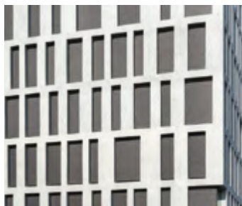
Estores de fachada
