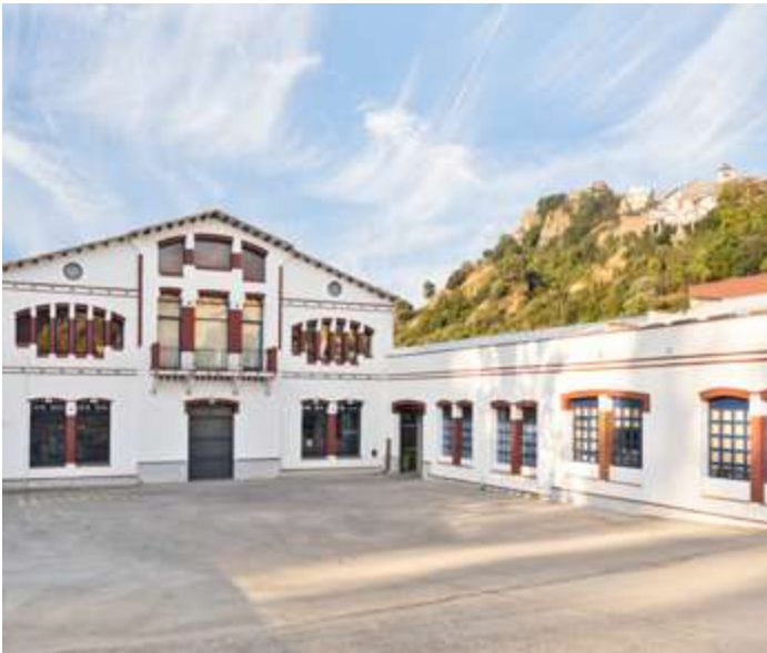
Weaving plant. Santa Maria d'Olió, Barcelona.
